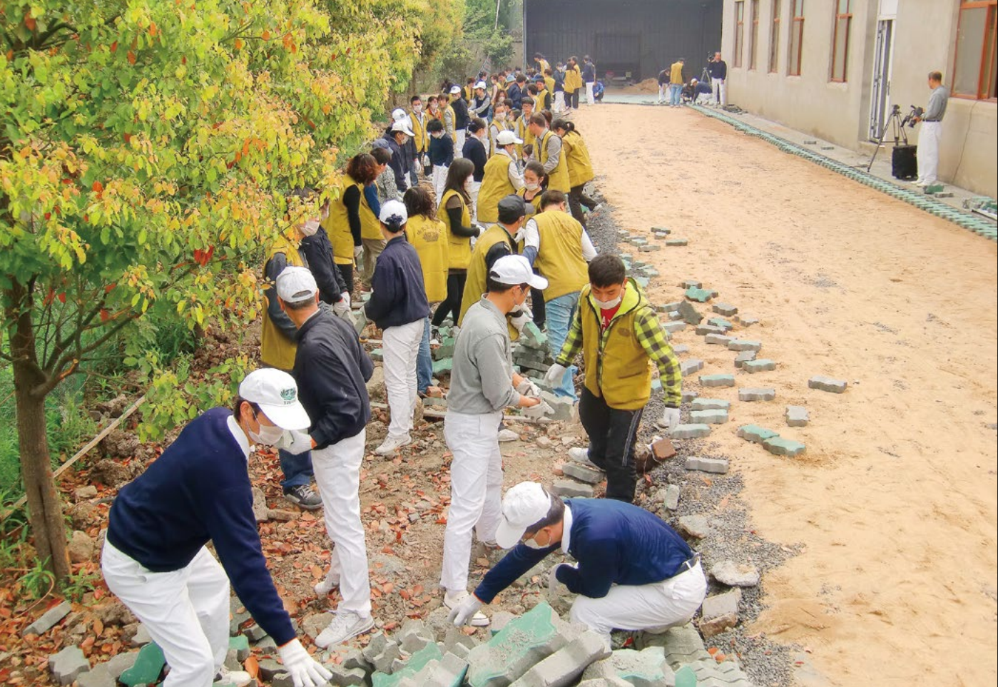
为建设环保教育站，志工合心协力一起铺设连锁砖。照片提供/慈济基金会
