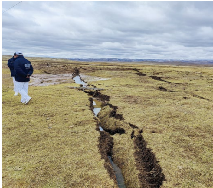
草原上，四处可见被地震震开的裂口。地处震央的黄河乡藏文寄宿制学校，此次校舍受损严重，部分房屋崩塌。摄影/王永安
