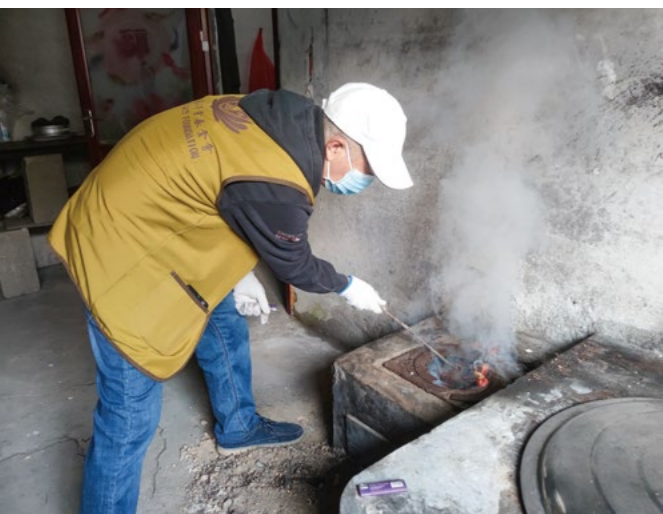
清理完炉膛里的尘土，志工引火试试炉子的烟道，查看烟道是否通畅。炉灶都好用了，辛大哥家的炕终于修好了。摄影/刘淑波
