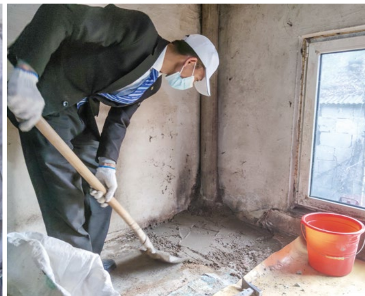
志工准备砖、灰、水泥等材料和工具，清掏塌陷部分的灰土，仔细将沙灰抹平，维修已塌陷一年多的炕。摄影/王骏、刘淑波
