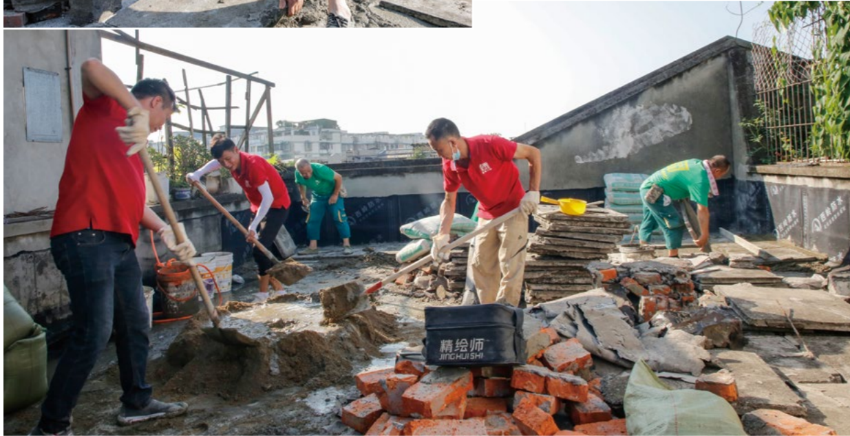
炙热高温下，搬砂、和水泥，爱心助力修缮屋顶，大家都在用自己的力量，做着力所能及的事情。
