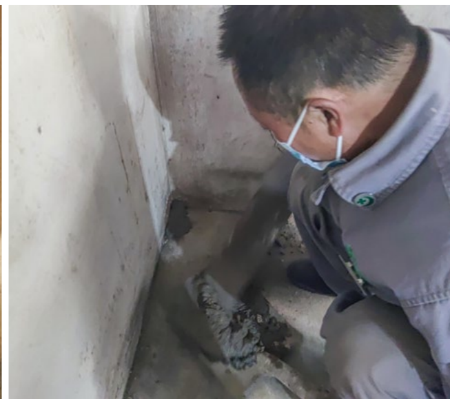
志工准备砖、灰、水泥等材料和工具，清掏塌陷部分的灰土，仔细将沙灰抹平，维修已塌陷一年多的炕。摄影/王骏、刘淑波
