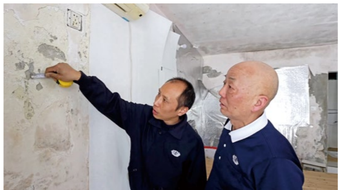
(下图) 10多位志工一起来做墙板。铲除剥落的墙纸、墙皮，用墙泥抹平墙顶；房顶则是一遍再一遍地被刷上涂料。 摄影/吴震
